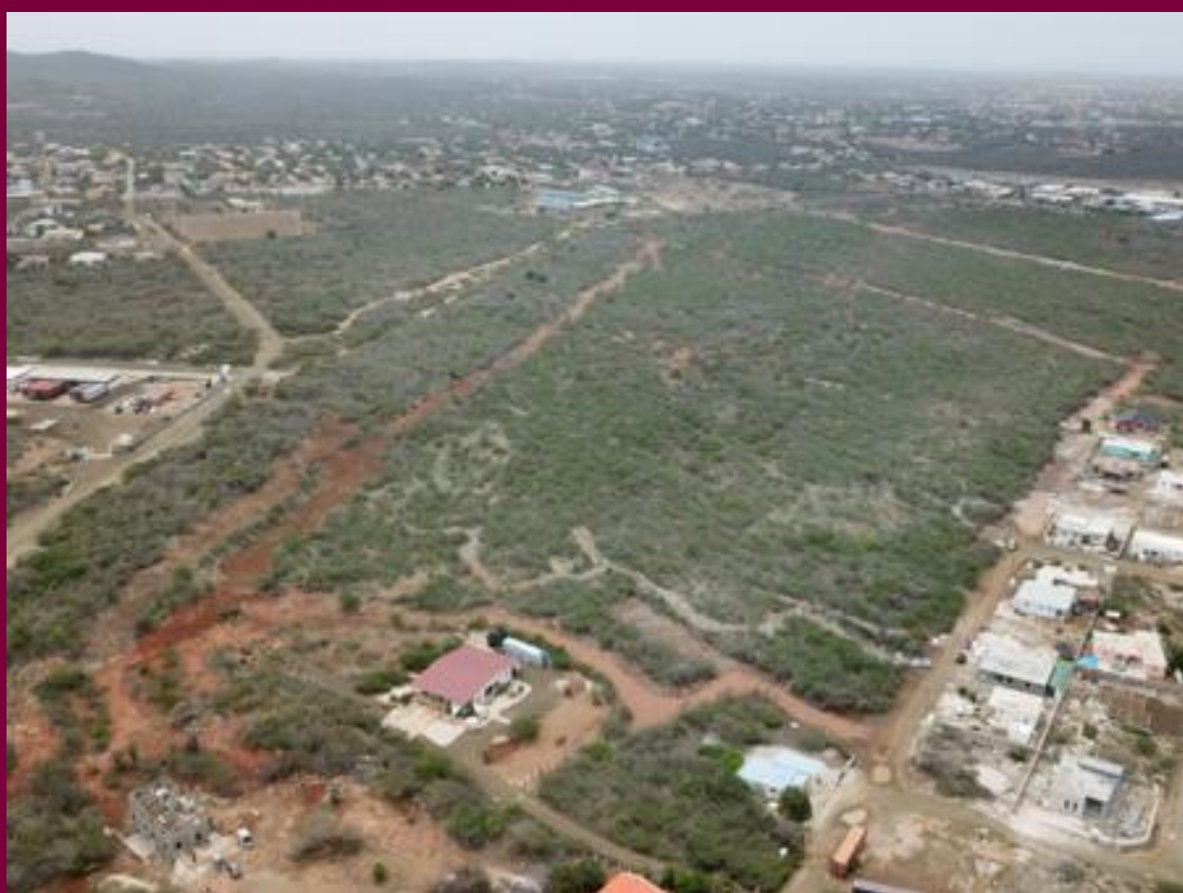
Een luchtfoto van de nieuwbouwlocatie Hato, bouwfase III 204 huurwoningen
